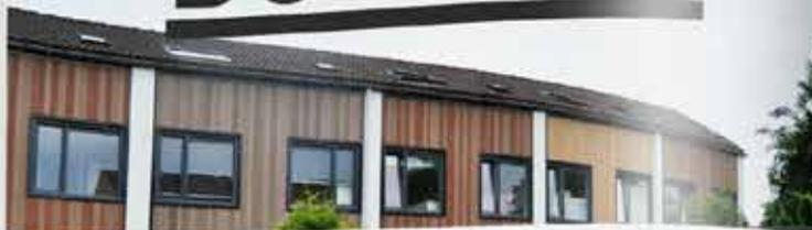
En el proyecto "De Driften" se creó un revestimiento en vertical cubriendo toda la estructura de la fachada. Se usaron dos tipos de paneles, Cirqlar siding CSP 105 y CSP 151 en 12 colores diferentes. Esto crea un espectacular juego de colores con un resultado final sorprendente. Es lo que se puede considerar seguro una buena y atractiva reforma. En total se usaron 3000m<sup>2</sup> de Cirqlar.
